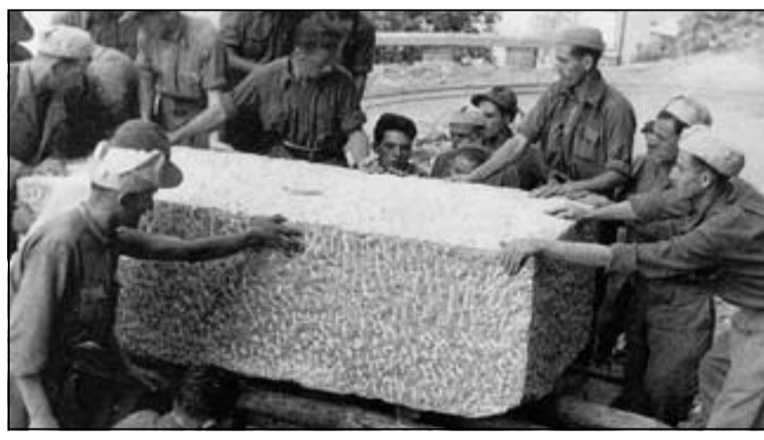
Due immagini degli alpini al lavoro per la costruzione della monumentale strada
